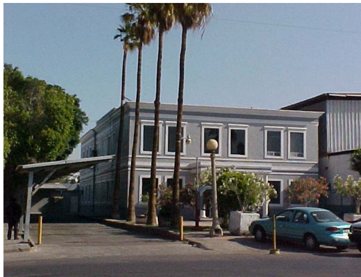
Edificio anexo a los Tribunales Federales (Mexicali)
