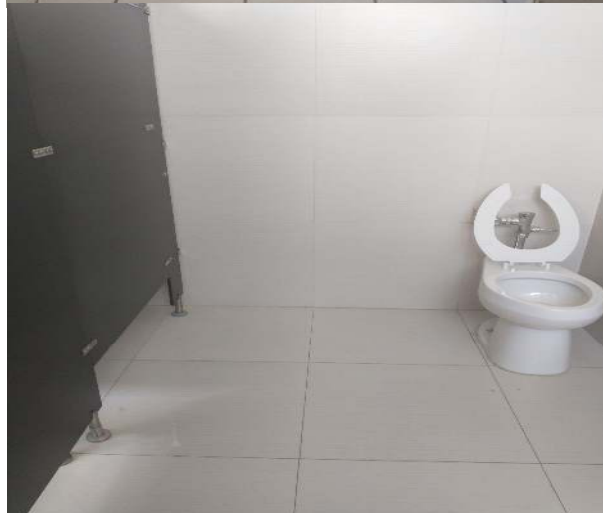
Foto. Baño planta baja Edificio 5A
