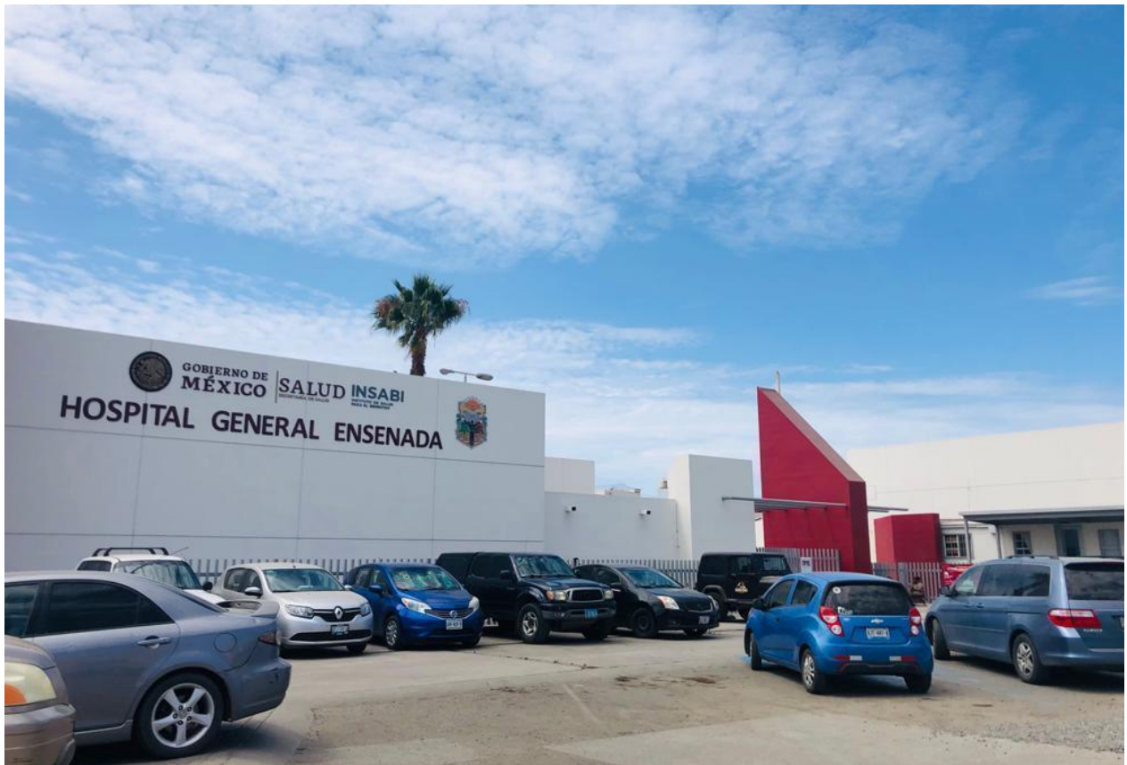
Figura 19. Infraestructura del Hospital General Ensenada.
