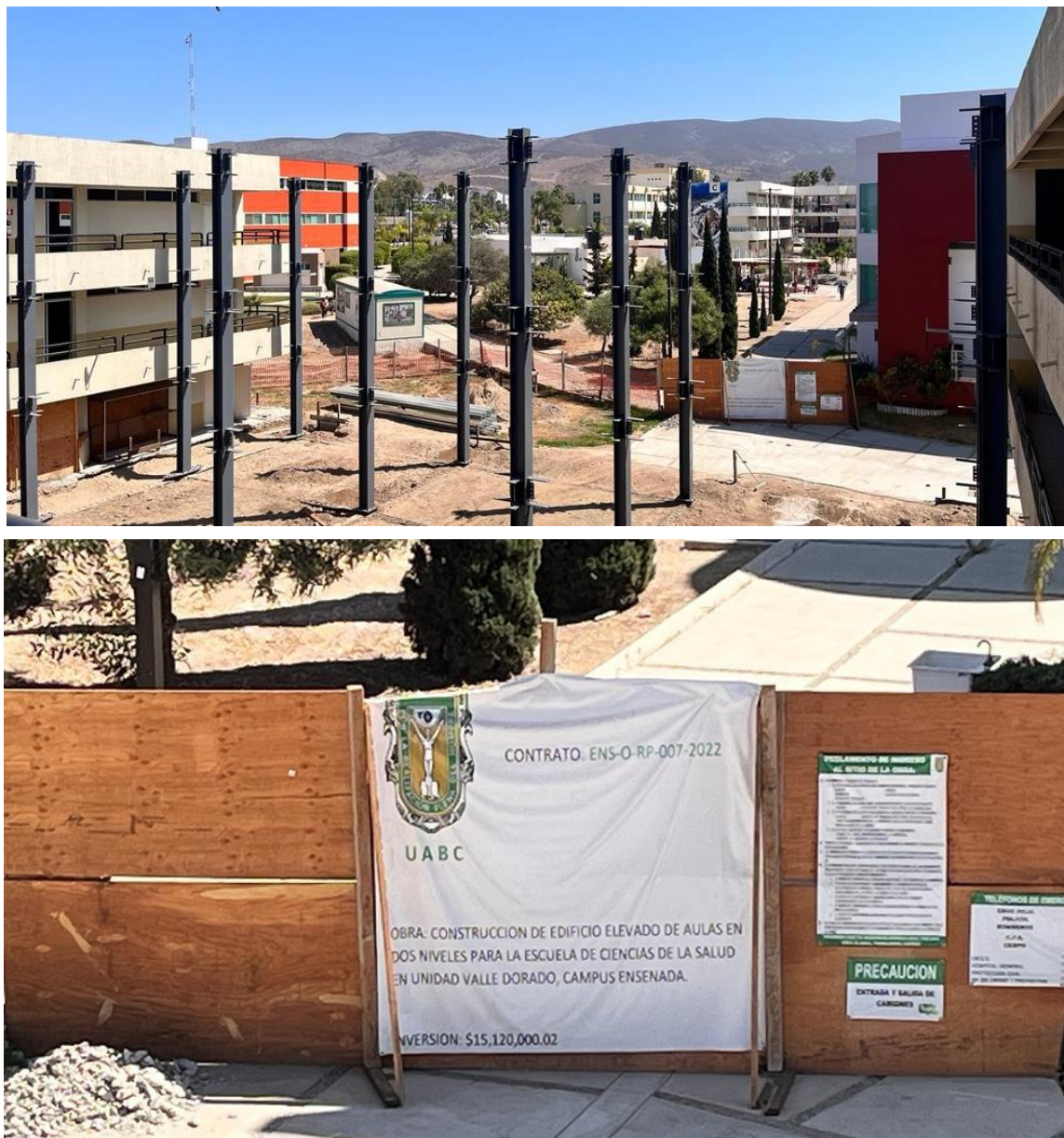
Figura 10. Edificio de aulas en construcción de la Escuela de Ciencias de la Salud, Unidad Valle Dorado.
