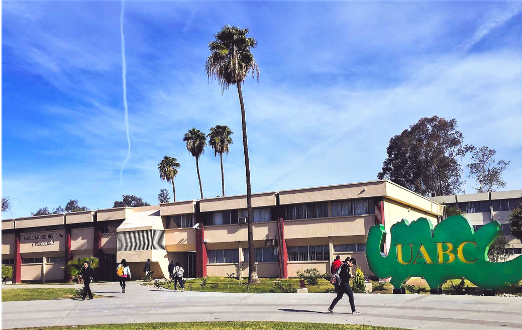
Figura 1. Edificio Central de la Facultad de Medicina y Psicología.
