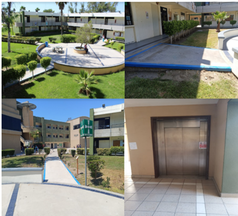
Figura 41. Estructura disponible para facilitar el acceso a personas con discapacidad de la Facultad de Humanidades y Ciencias Sociales (FHyCS)
