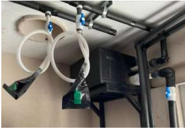
Figura 11. Sistema de refrigeración para el proceso de fermentación con placas de enfriamiento
