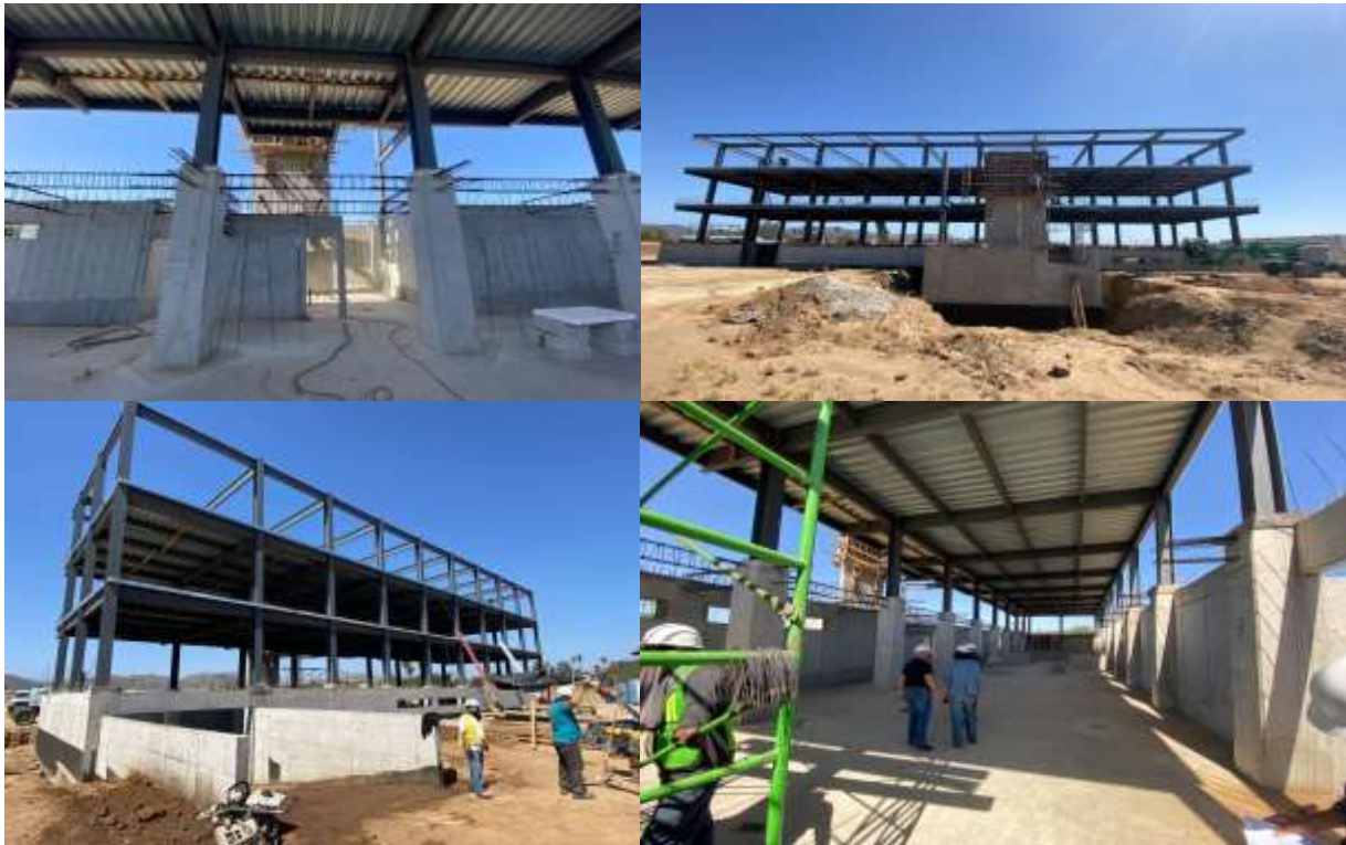
Figura 1. Avance de la construcción
