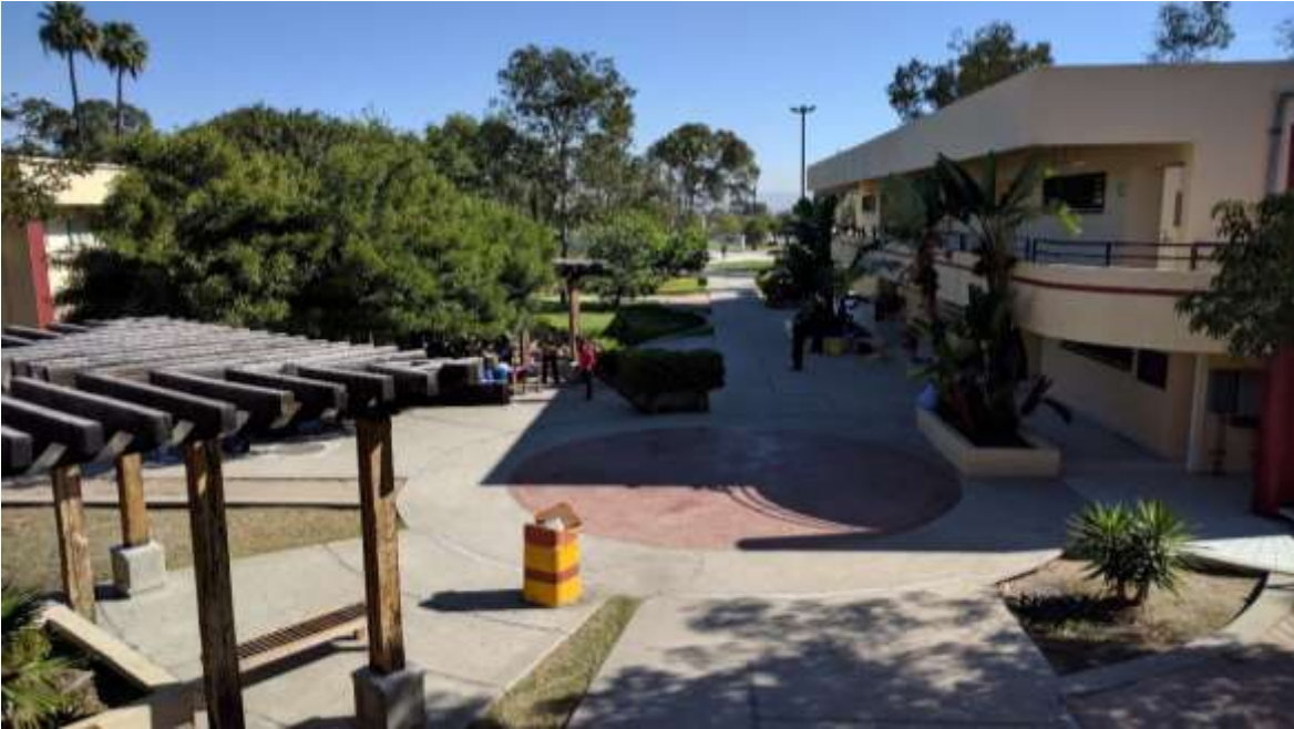
Figura 5. Edificio 1B de la Facultad de Medicina y Psicología. Alberga 8 aulas con capacidad de 30 alumnos cada una.
