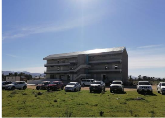
Figure 13. Elaboración propia: Edificio en construcción Unidad "El Porvenir"
