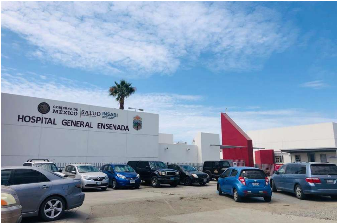
Figura 20. Infraestructura del Hospital General Ensenada.
