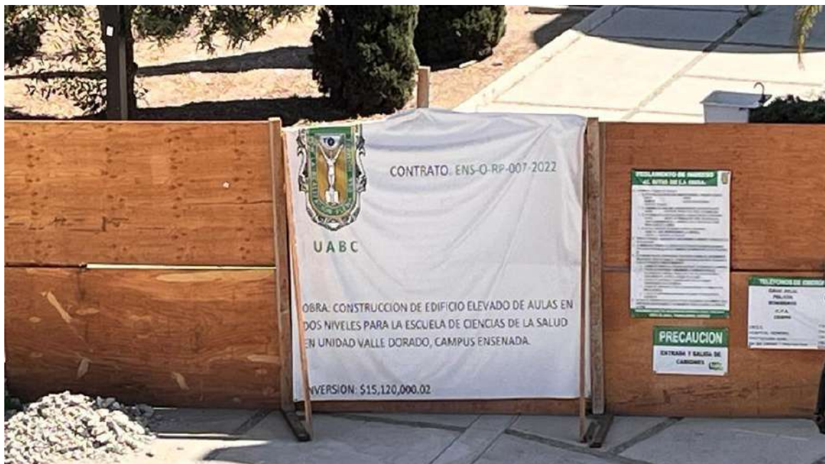
Figura 11. Edificio de aulas en construcción de la Escuela de Ciencias de la Salud, Unidad Valle Dorado.
