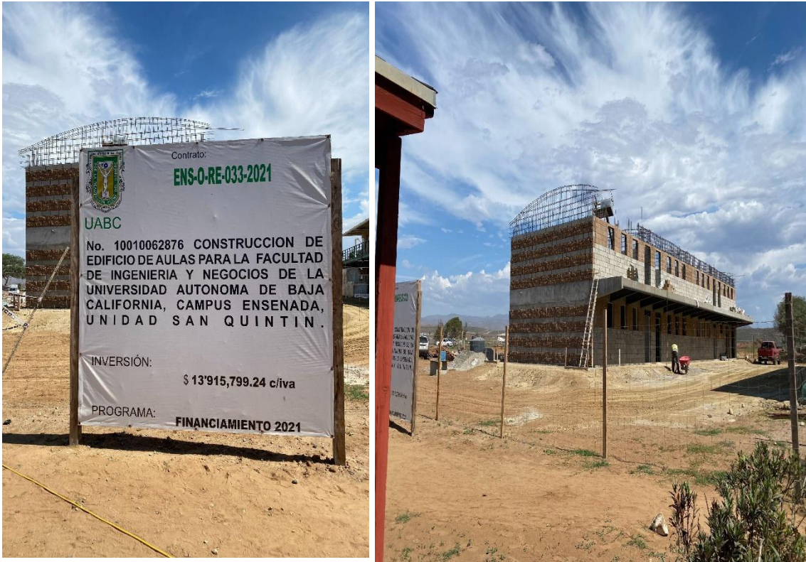
Figura 03. Avance de la construcción del nuevo edificio
