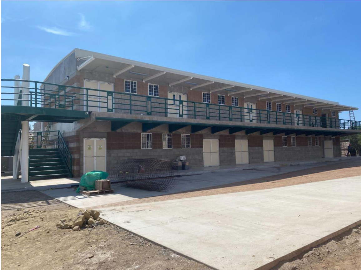
Figura 16. Avance de la construcción de la nueva audiovisual (segunda planta).
