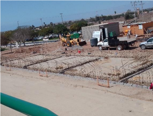
Figura 03. Avance de la construcción del nuevo edificio
