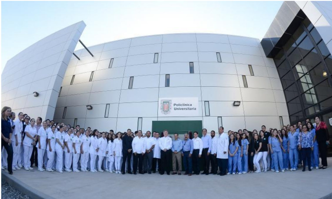
Figura 7: Policlínica Universitaria del Campus Mexicali, sede de los posgrados de Odontología, Unidad de Ciencias de la Salud, en la Universidad Autónoma de Baja California.
