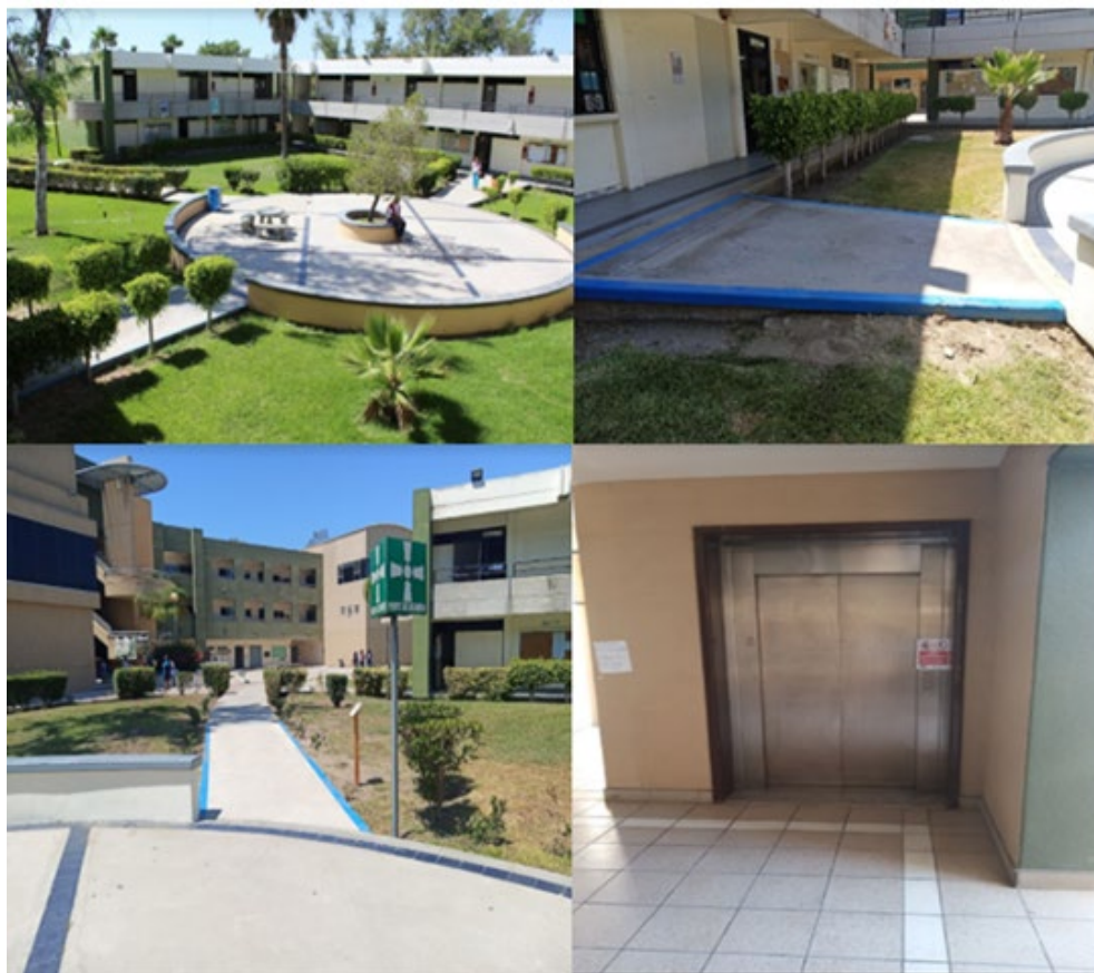
Figura 36. Estructura disponible para facilitar el acceso a personas con discapacidad de la Facultad de Humanidades y Ciencias Sociales (FHyCS)
