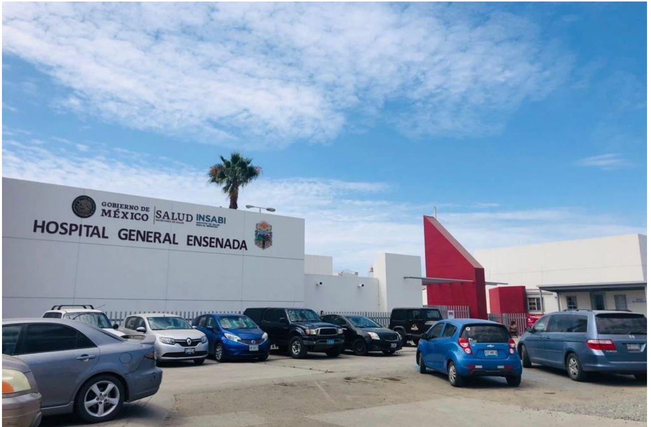
Figura 19. Infraestructura del Hospital General Ensenada, Baja California.
