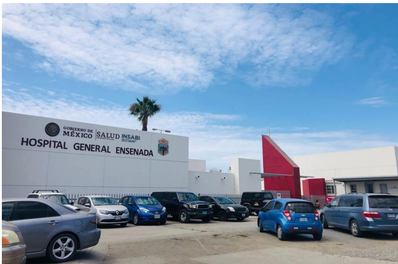
Figura 20. Infraestructura del Hospital General Ensenada, Baja California.
