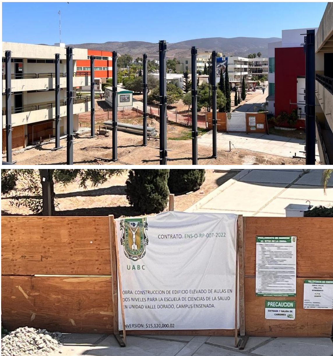
Figura 11. Edificio de aulas en construcción de la Escuela de Ciencias de la Salud, Unidad Valle Dorado.
