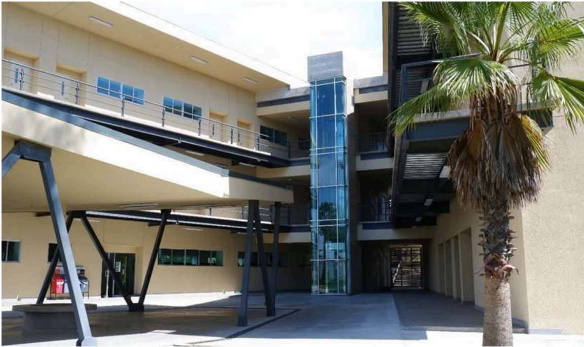
Figura 9. Edificio 1D de la Facultad de Medicina y Psicología. Alberga 10 aulas, la Coordinación de Investigación y Posgrado.
